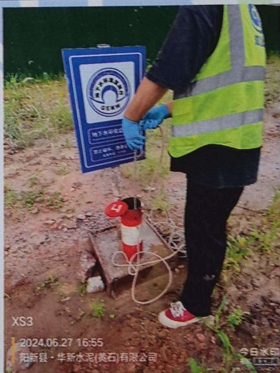
3 号井地下水采样点☆3
